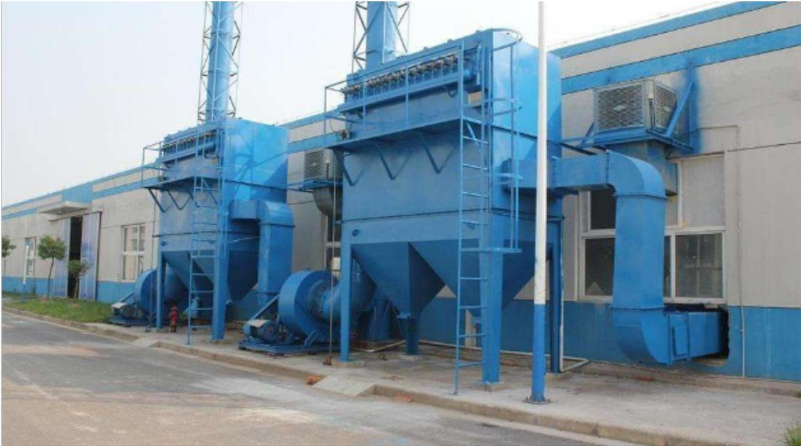
袋式除尘器的应用已有百余年的历史，其比较大的优点是除尘效率高（达99.99%以上），排放浓度可达到 $10\text{mg}/\text{m}^3$ 以下，且分级效率也很高，对 $2.5\mu\text{m}$ 以下的微细颗粒物也有很好的捕集效率，因此得到的应用。但袋式除尘器经过多年的运行也暴露出一些问题，如滤袋易损坏、结露、运行阻力高、清灰失灵、灰斗卸灰不畅等。造成袋式除尘器运行出现问题的因素有很多，除了除尘器自身因素外，操作、管理不当也是造成其在运行中出现问题的重要原因。本文对目前袋式除尘器在运行过程中经常出现的问题进行了分析讨论。雁塔区除尘设备配件除尘设备目前已应用于我国电力、水利、钢铁、化工等行业。
